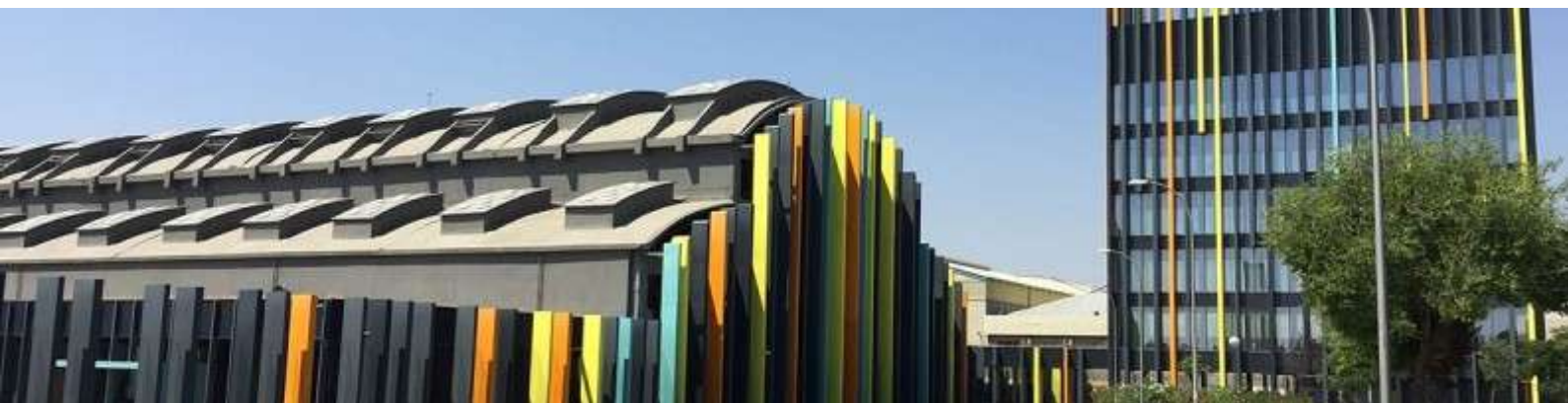
Imagen: La Nave Madrid
